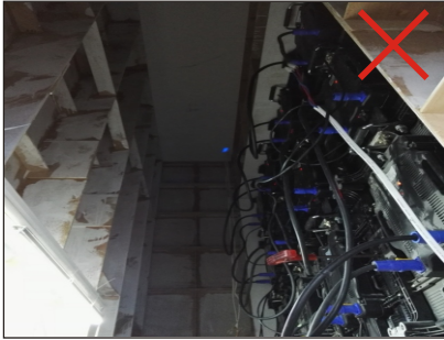
操作间封顶, 不合格 操作间未封顶, 合格 带有电视墙或其他电路设备的操作间必须散热良好, 不得封顶。
