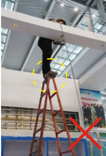
正确的登高作业:2人,1人登高、1人看护,不得站立在梯子最顶层作业,不得使用劣质人字梯。
