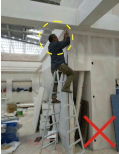
正确的登高作业:2人,1人登高、1人看护,不得站立在梯子最顶层作业,不得使用劣质人字梯。
